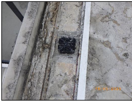
รูปที่ 2-38 รางระบายน้ำฝนชั้น 33
